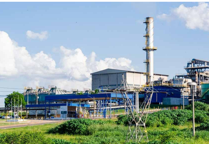
Termelétrica tem capacidade instalada de 45 MW e está localizada em Lins, município do interior paulista (Crédito: Divulgação JBS)
